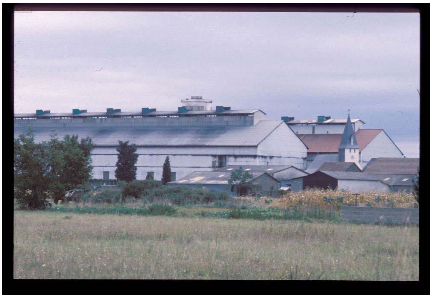
▲ L'usine Pechiney à Noguères en octobre 1991 ©CRÉDIT PHOTO : CHRISTIAN RIGABERT
