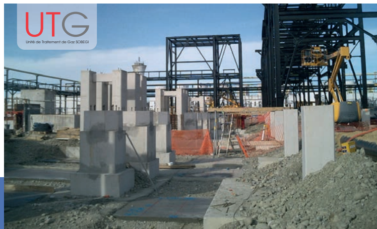
Chantier de la nouvelle Unité de Traitement de Gaz SOBEGI. Vue des fondations des compresseurs et des nouvelles charpentes mécaniques destinées à supporter les tuyauteries.
