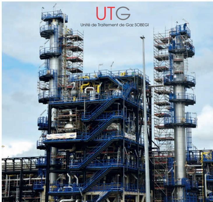
SOBEGI réceptionne le chantier UTG en juin 2013
