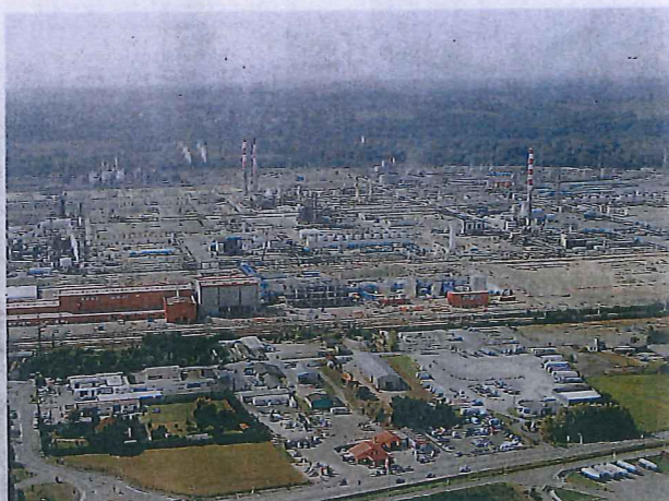
de la plate-forme de Lacq, 16 hectares ont été dépollués afin de permettre sa construction. © CHEMPAC
