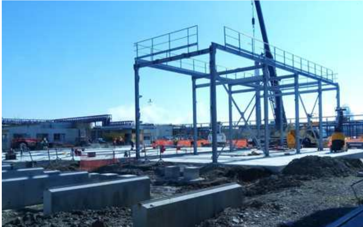
Les travaux pour créer les centrales Pegaze ont débuté sur la plateforme Induslacq. La première sera opérationnelle à l'automne. © DR
